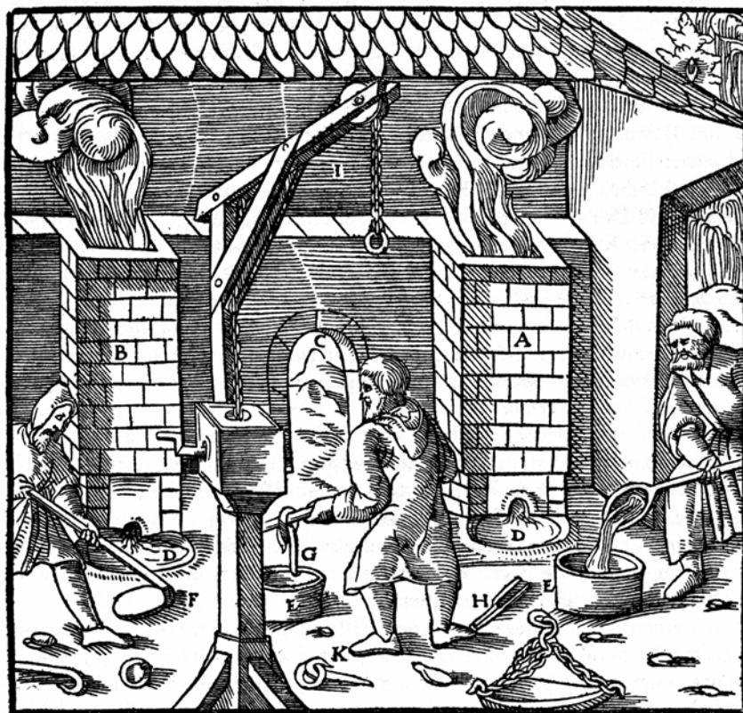
Der Ofen zum Verschmelzen der Schlacken A. Der Ofen zum Legieren von Kupfer mit Blei B. Tür C. Der in die Erde eingelassene Spurtiegel D. Kupferne Form E. Das Streichholz F. Der Haken G. Das gesplattene Holz H. Der Ausleger des Kranes I; sein Kettenhaken K.
